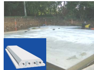
U-Wert: 0,15 W/m 2 K inkl. Estrichaufbau Mehrsparteneinführung gegen Berechnung.
